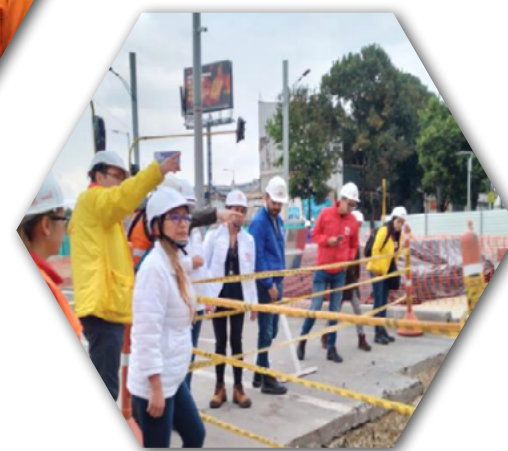
Inspección a terreno Proyecto Metro Localidad de Chapinero
