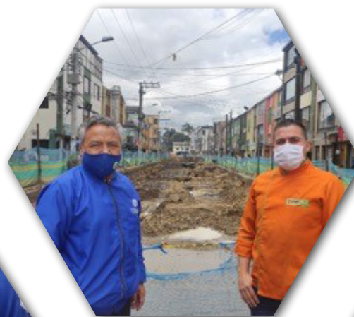
Inspección a terreno contrato IDU 1563-2018
